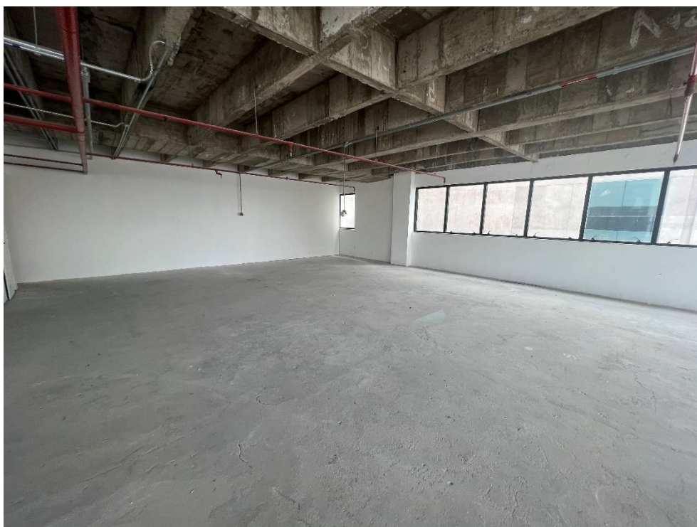
Vista geral do pavimento tipo
