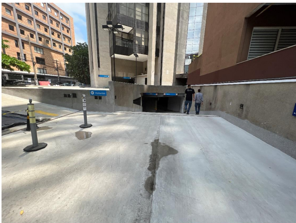
Rampa de acesso aos estacionamentos
