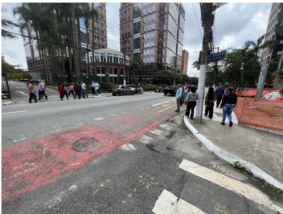
Vista da Rua Alexandre Dumas, imóvel à direita
