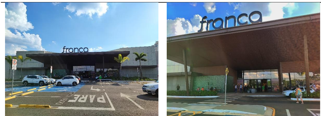
FOTOS DA FACHADA DO IMÓVEL
