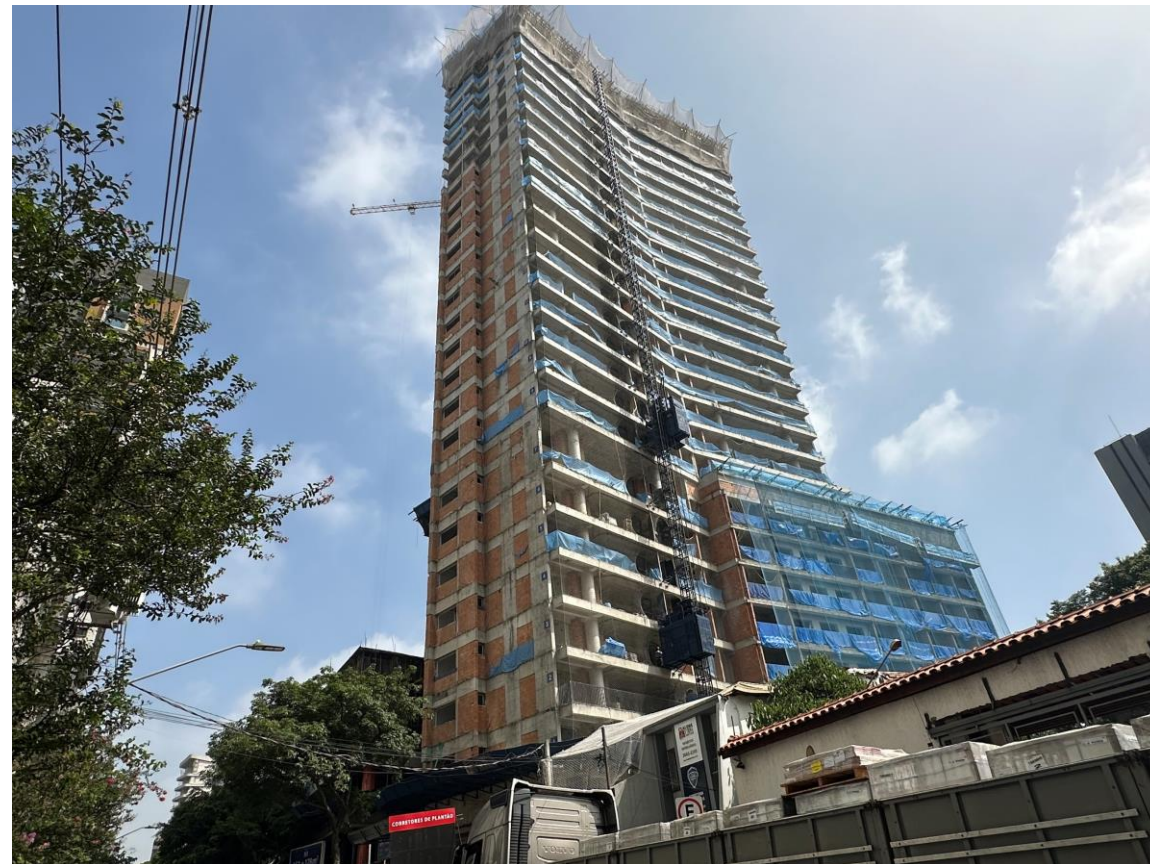
Foto da obra.
