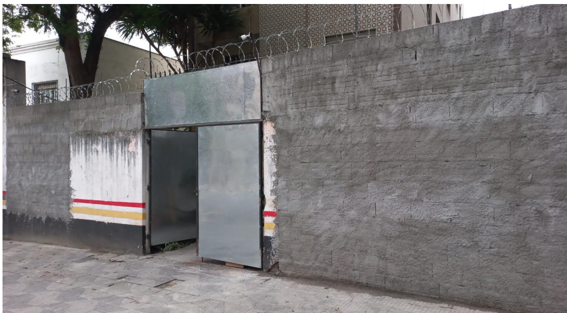
Obra de reforço perimetral
