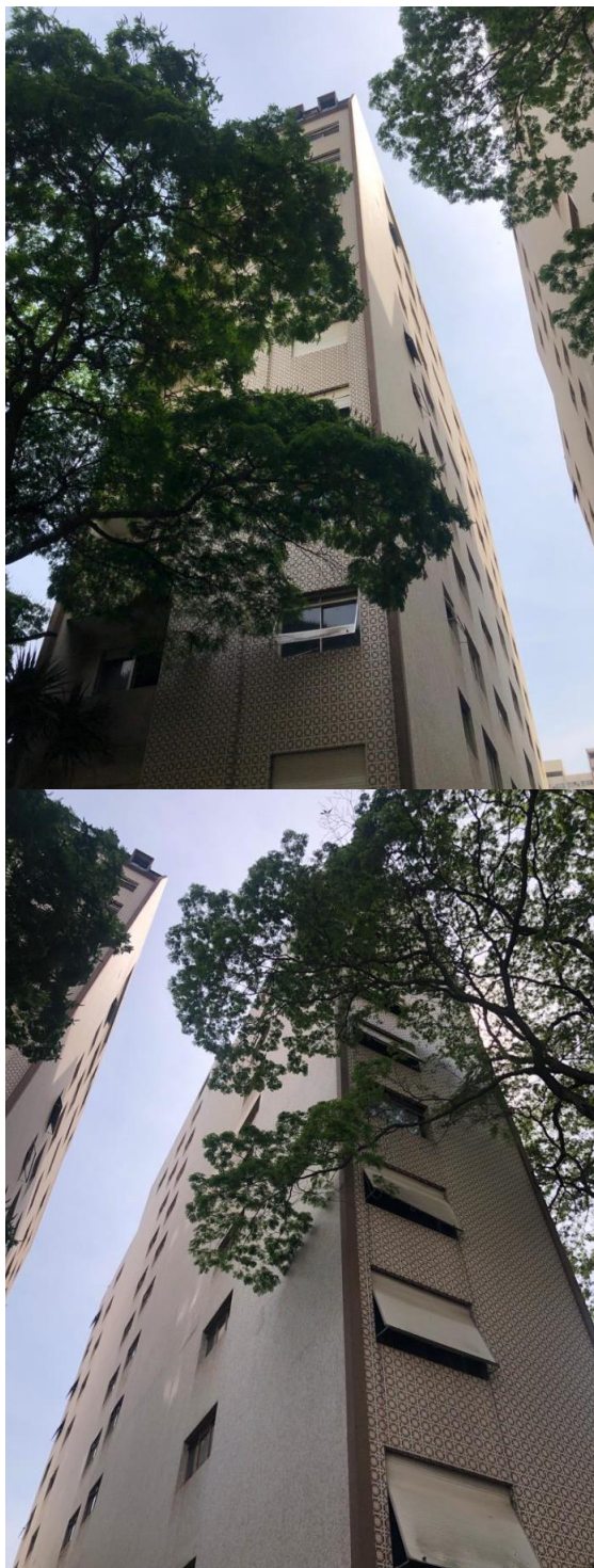
Torre 486 à esquerda e Torre 484 à direita.
