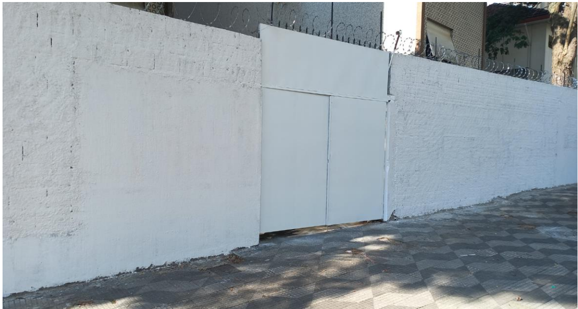
Muro frontal após pintura
