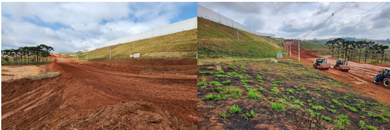
Fotos da via em obra.
