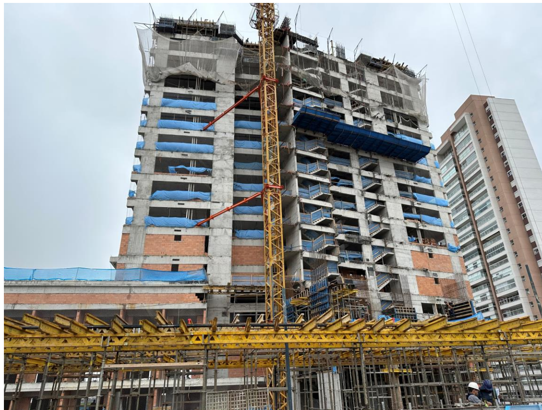
Foto da obra.
