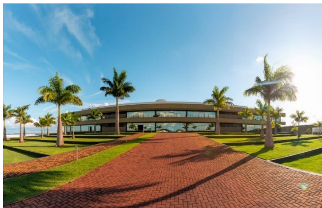
Fachada do Porto Seco Sul de Minas.
