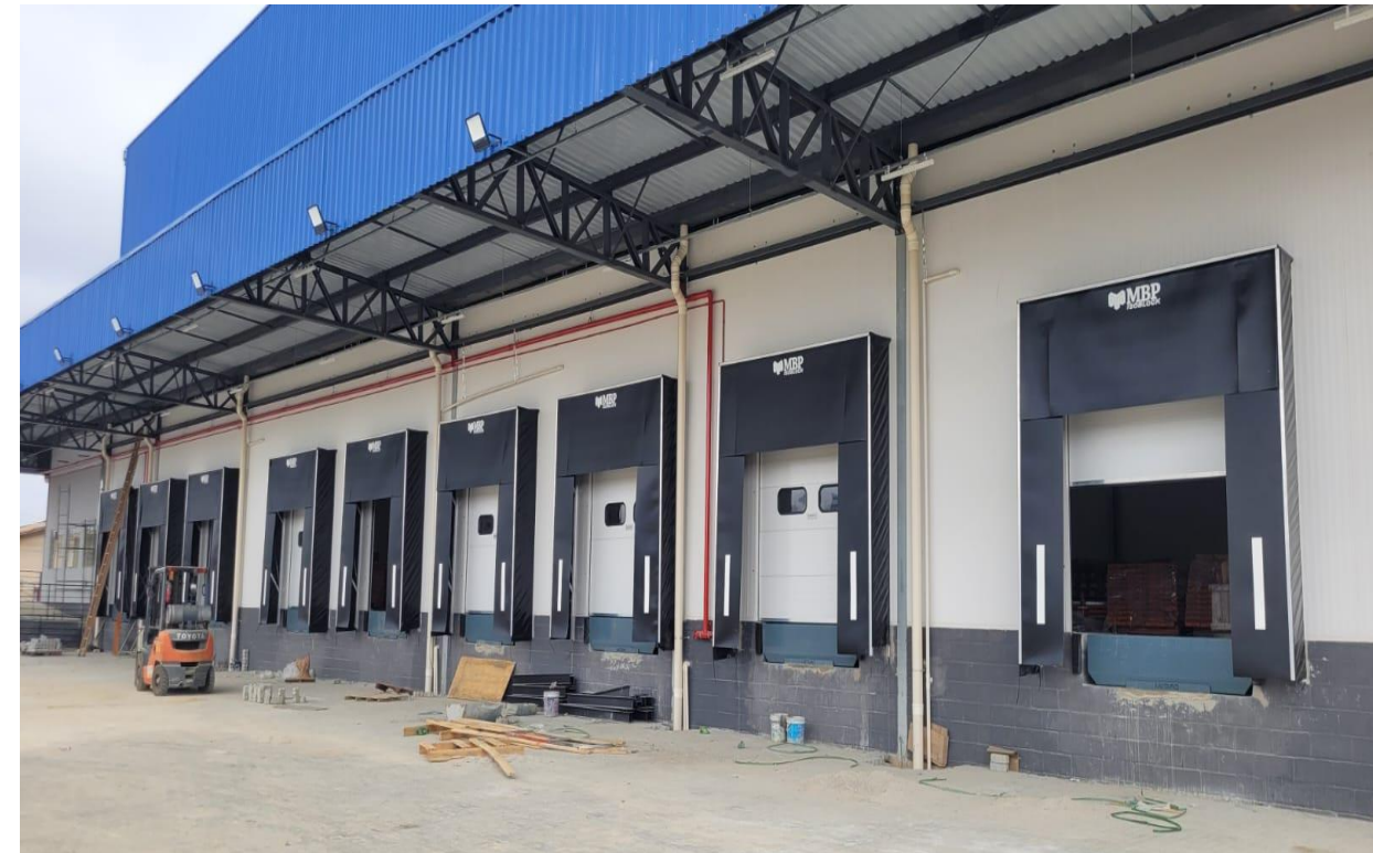
Instalação das seladoras das portas.
