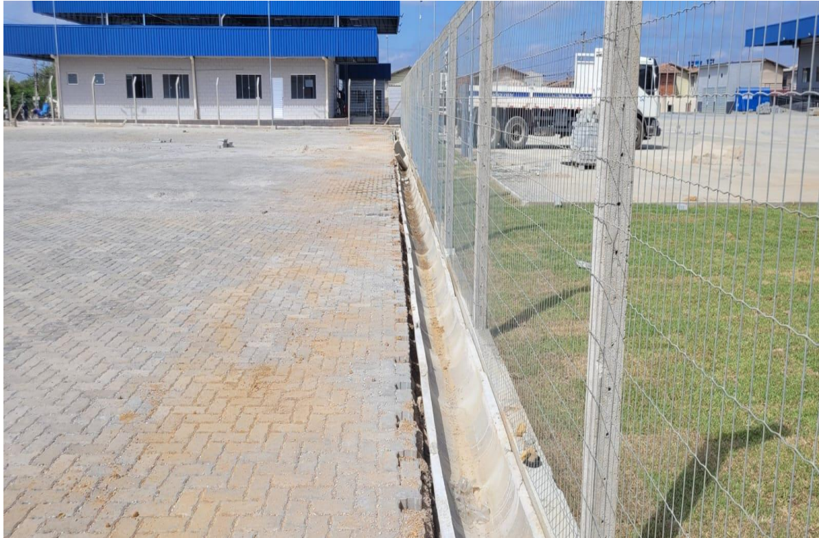
Execução de canaletas nos pátios externos.
