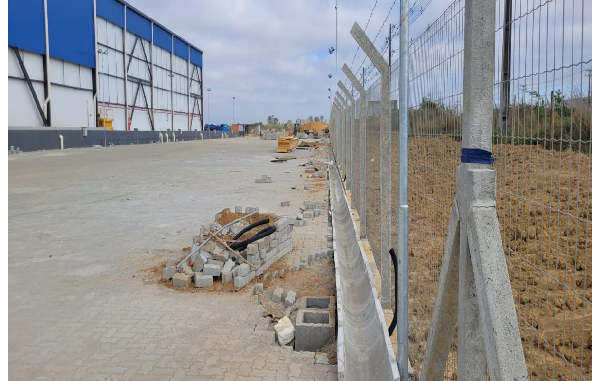
Execução de canaletas nos pátios externos.
