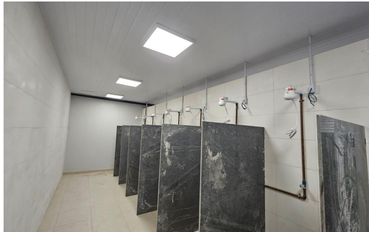
Instalação das divisórias em granito e armários do vestiário do prédio administrativo.
