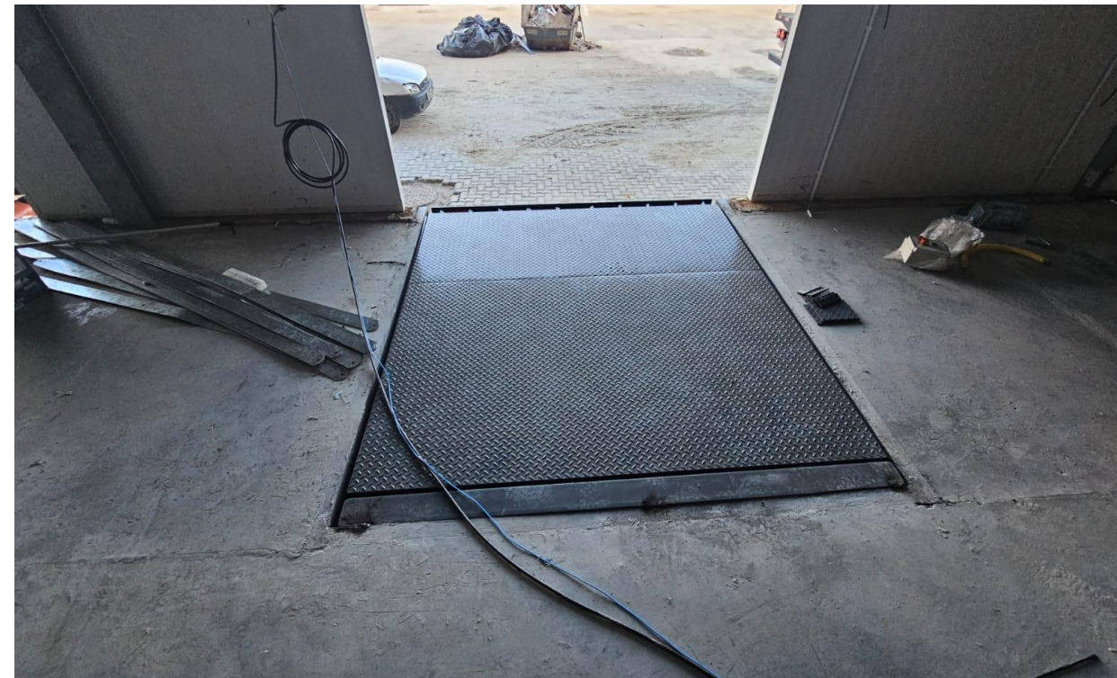
Instalação das niveladoras de doca.
