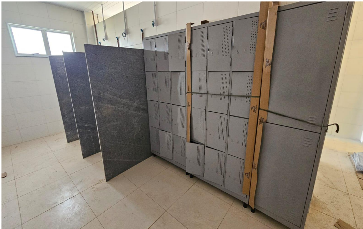
Instalação das divisórias em granito e armários do vestiário do prédio administrativo.
