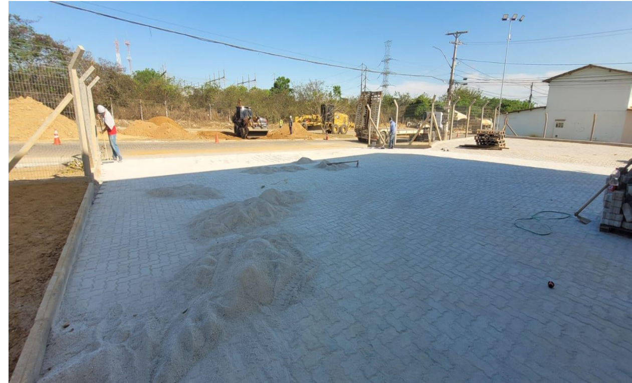
Assentamento do pavimento intertravado.
