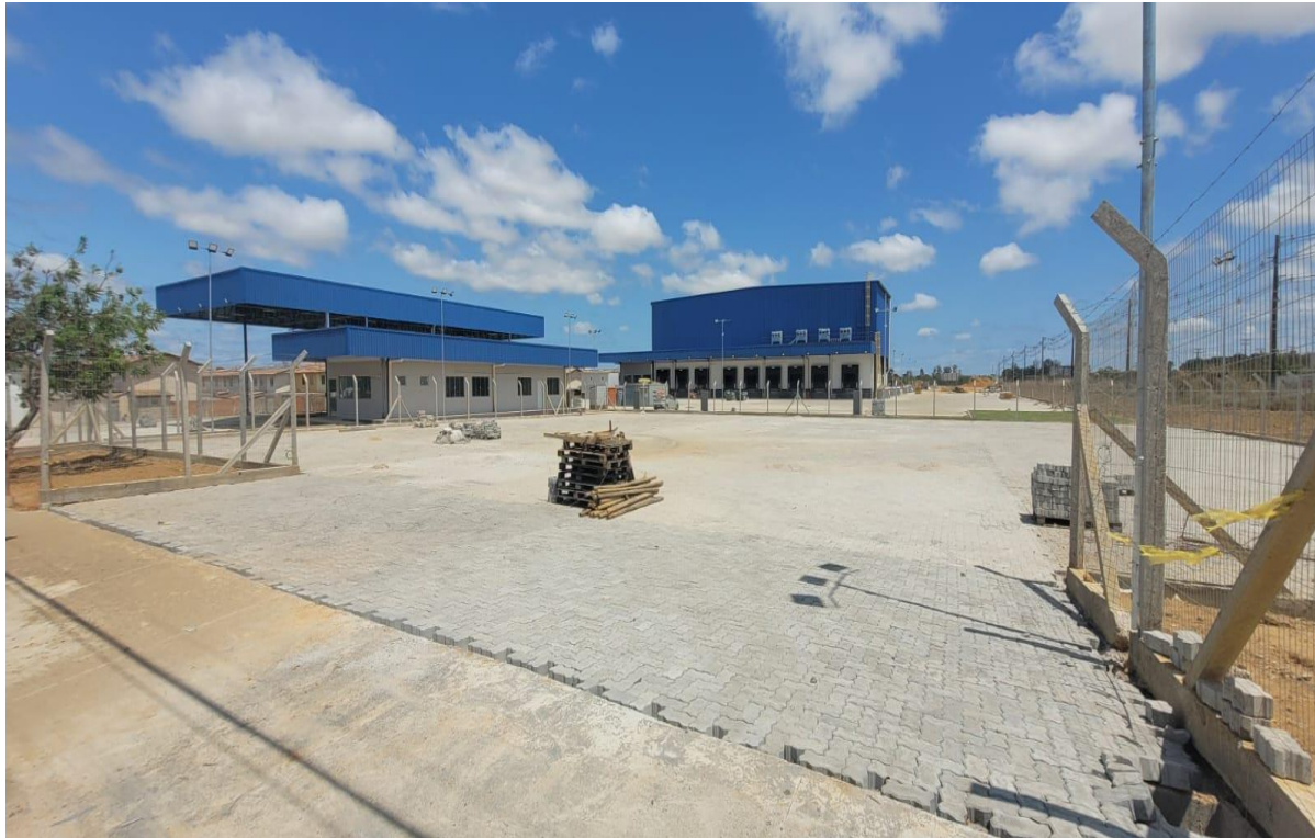
Assentamento do pavimento intertravado.
