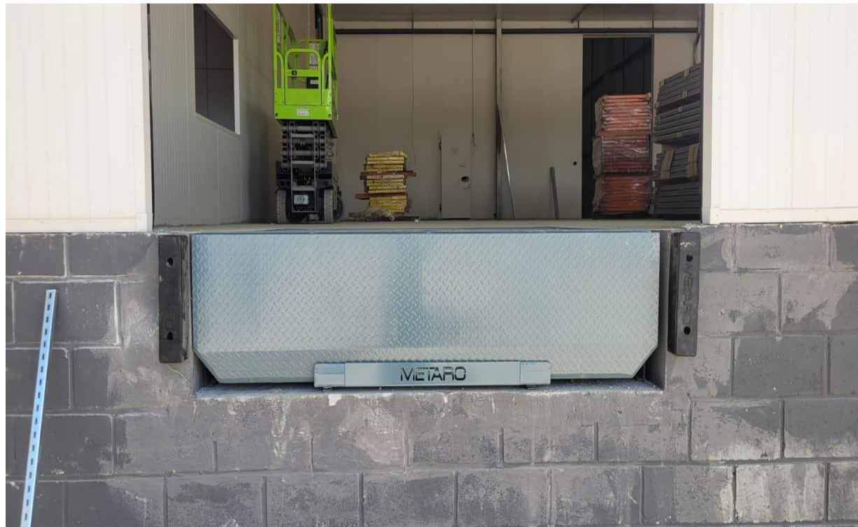
Instalação das niveladoras de doca.
