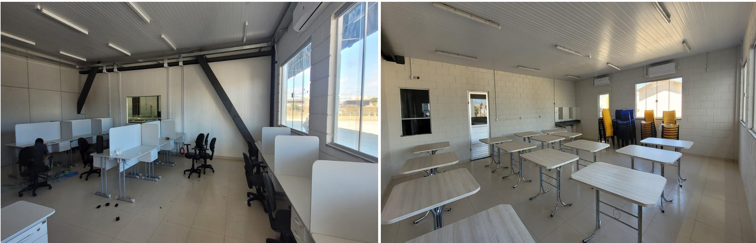
Montagem do mobiliário do prédio administrativo.
