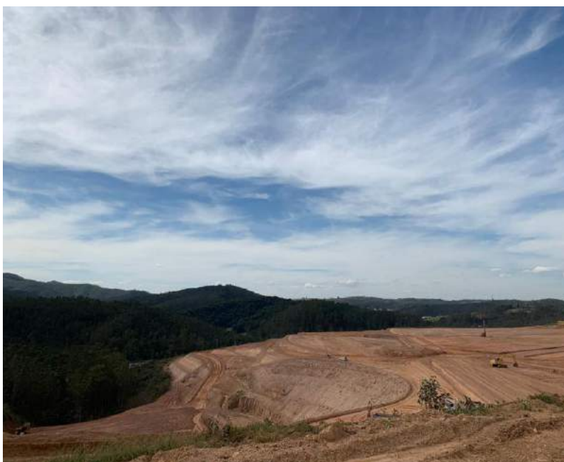
Execução de obras
