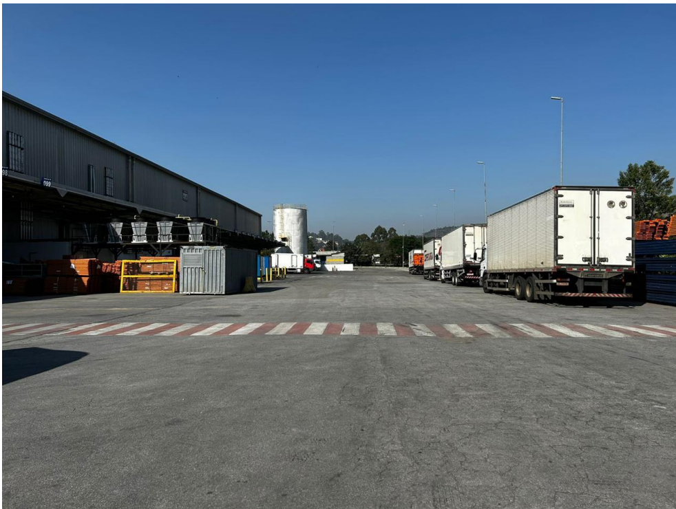
Vista externa do galpão
