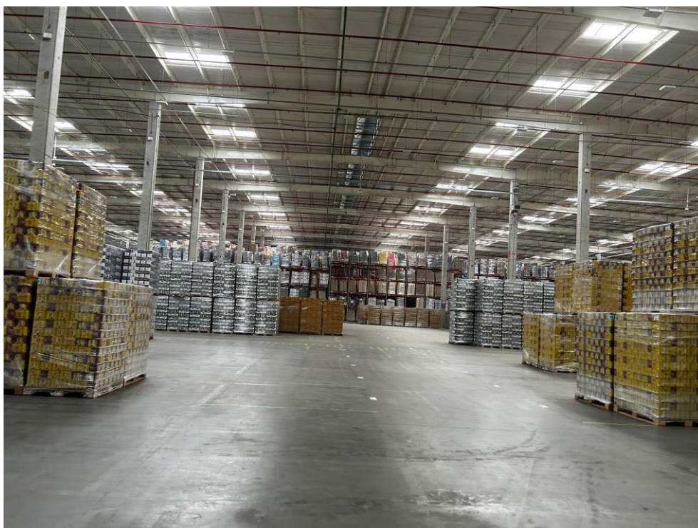
Vista interna do galpão
