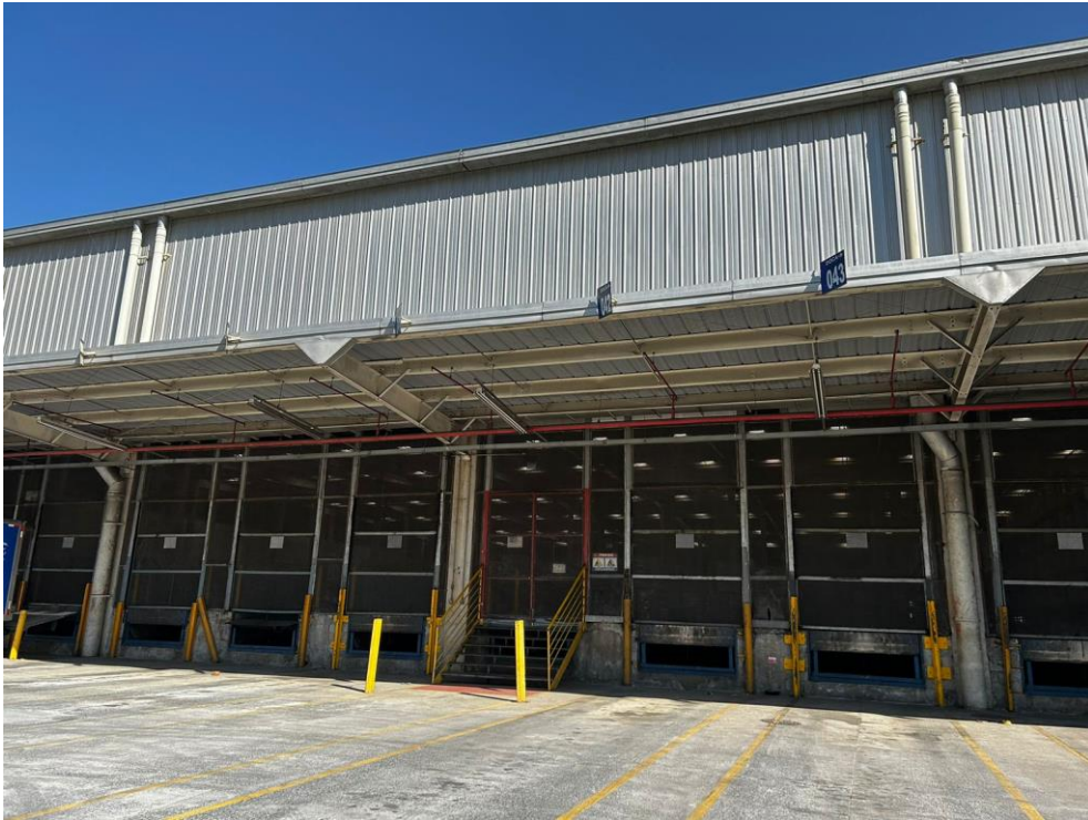
Vista externa do galpão
