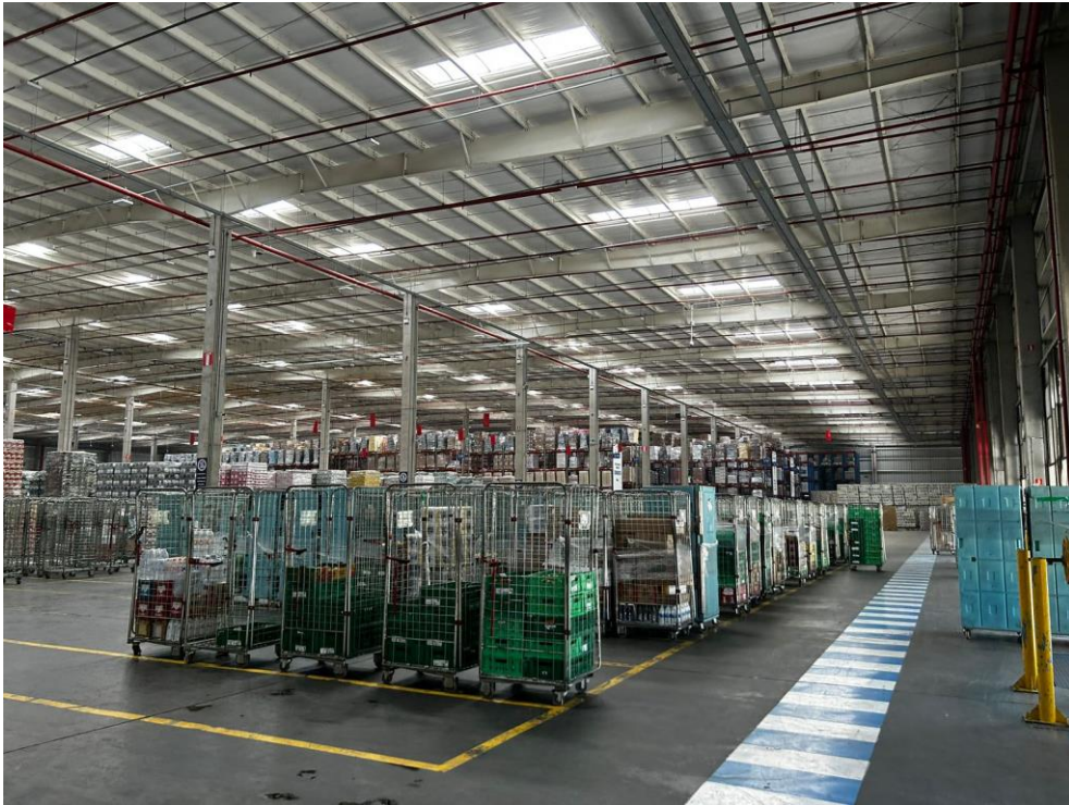
Vista interna do galpão
