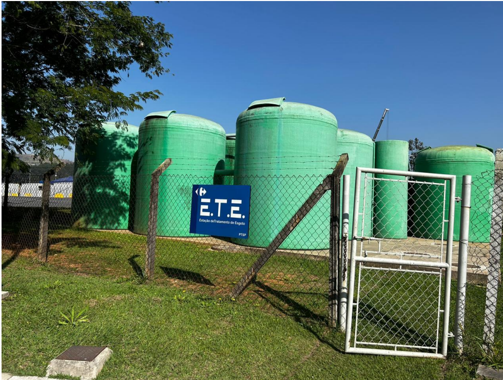
Vista externa da ETE
