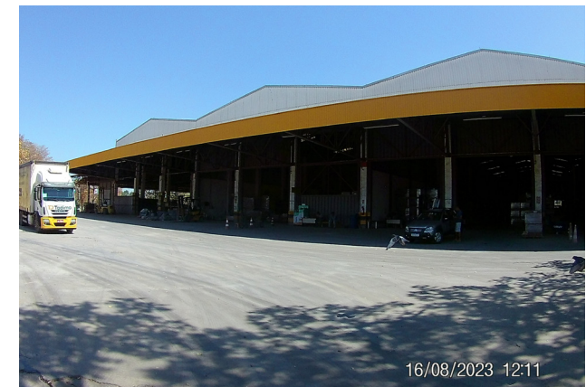
Fachada lateral do galpão
