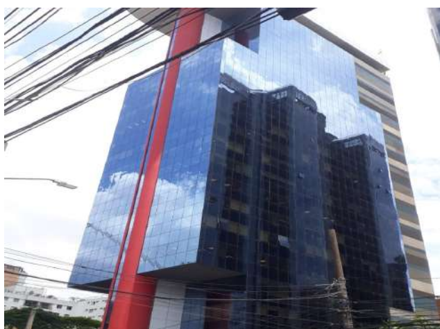
Vista Externa do Imóvel Avaliando.
