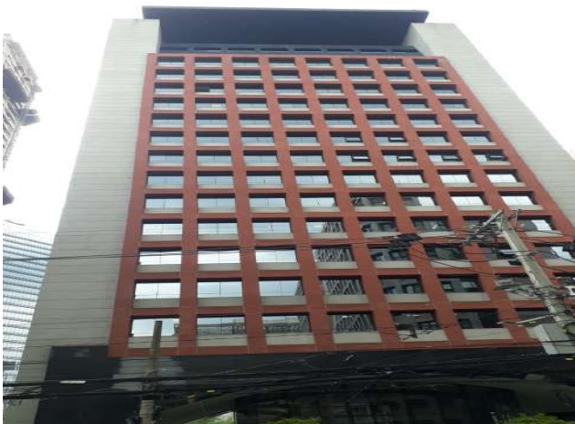
Vista Externa do Imóvel Avaliando.
