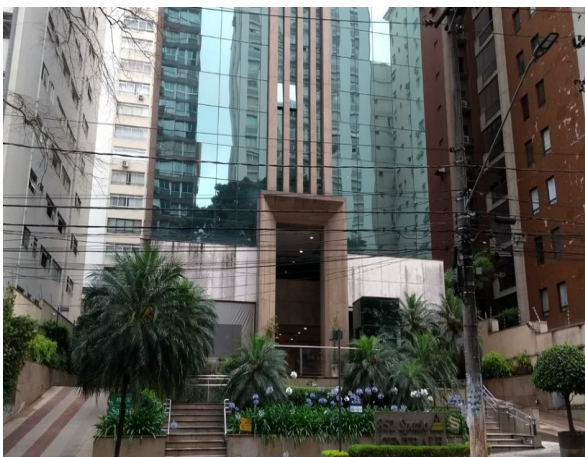
Vista Externa do Imóvel Avaliando.
