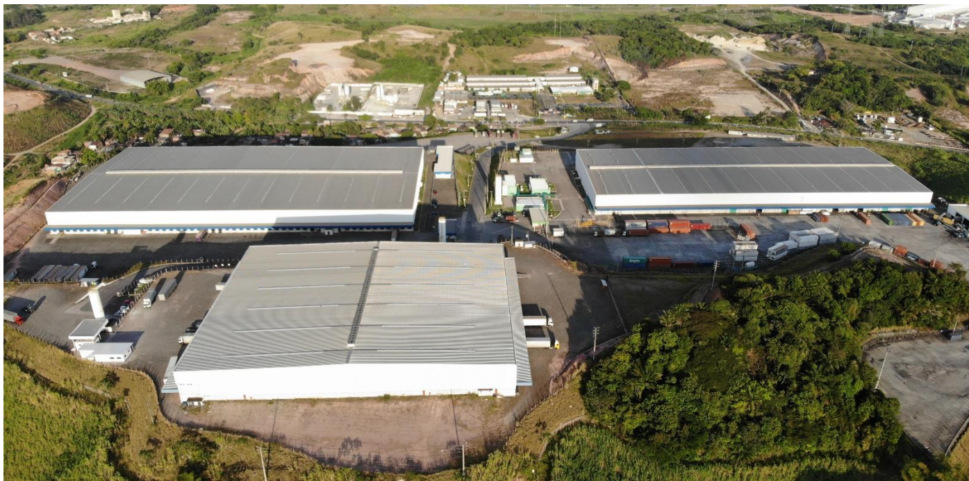
Imagem 3: Foto Aérea dos Galpões
