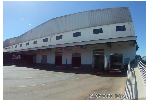
Fachada lateral do galpão de SantaCruz
