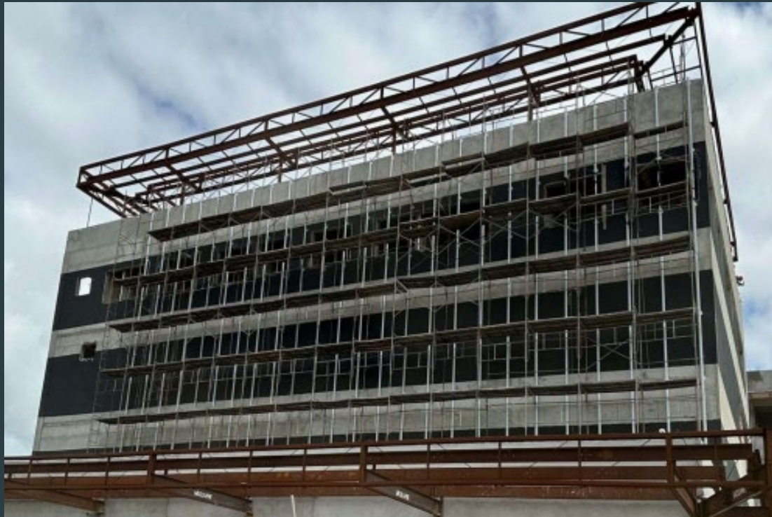
Fachada – Pele de Vidro
