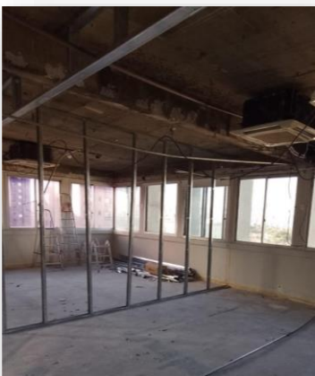
Início da obra
