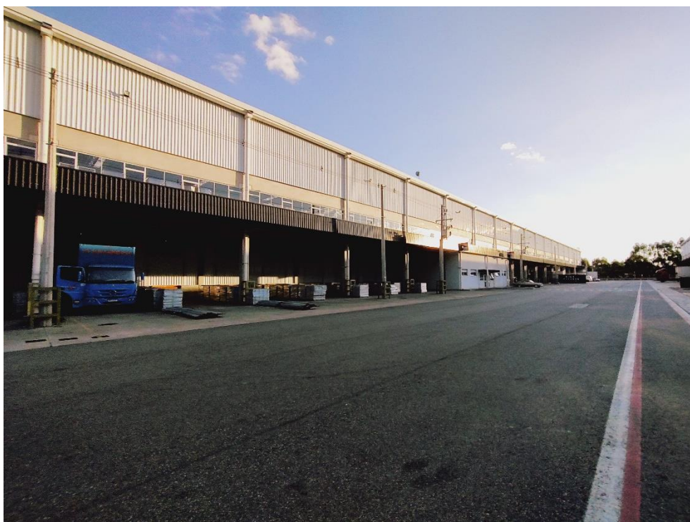
Vista externa do galpão
