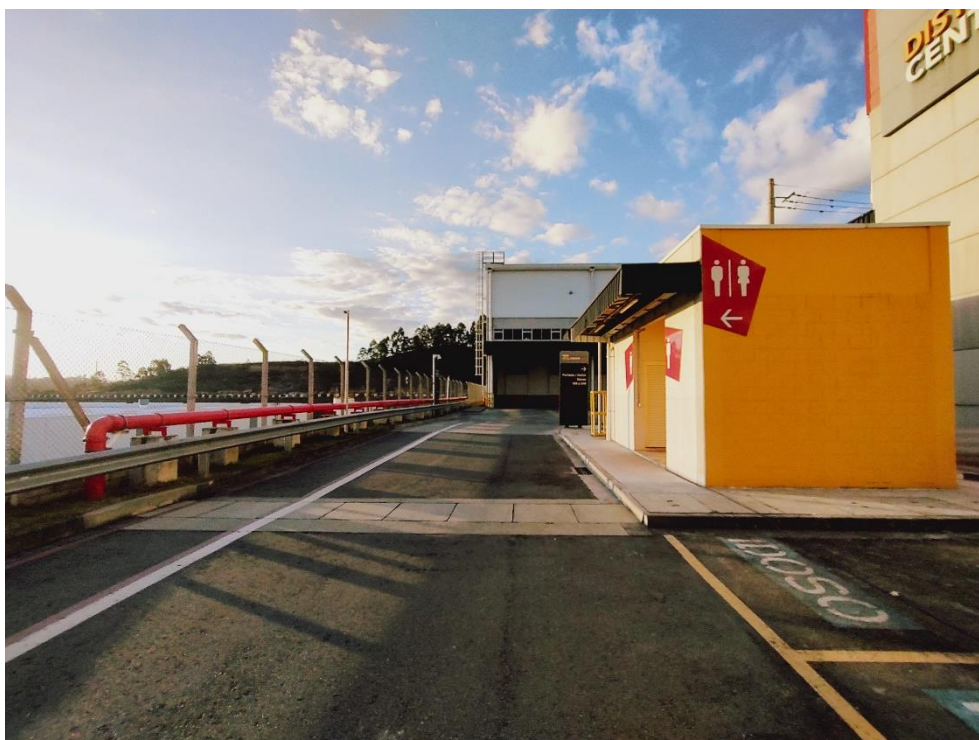
Vista da área técnica (caixa d'água)
