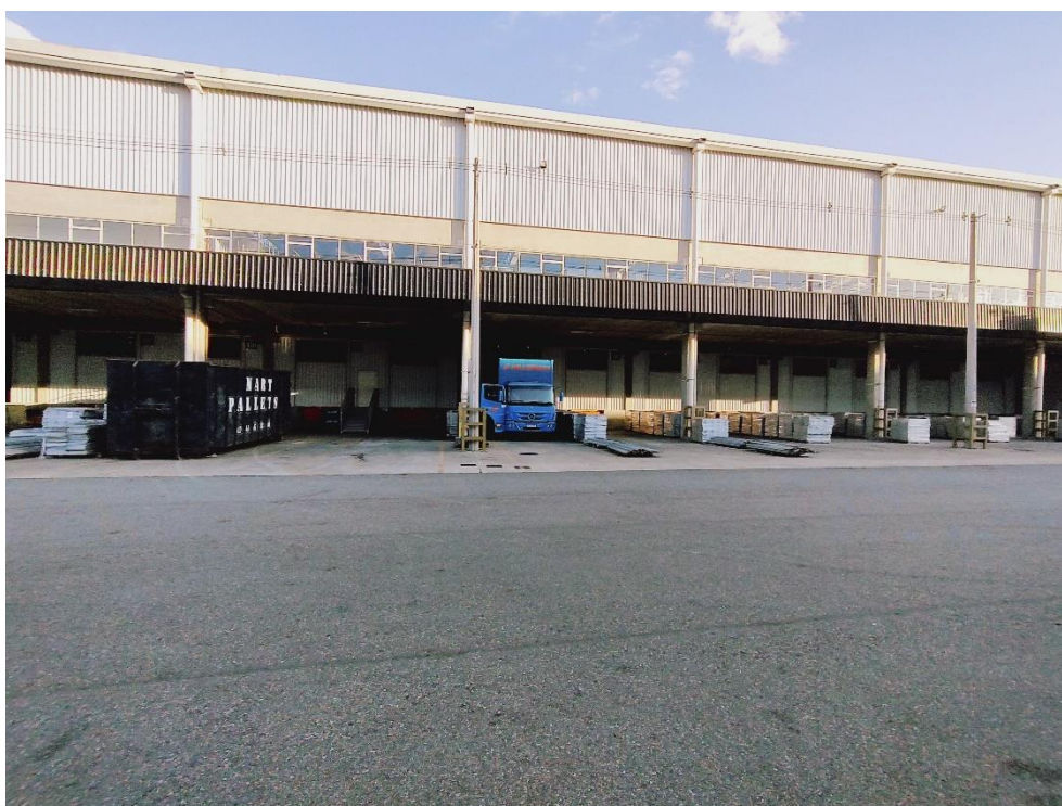
Vista externa do galpão
