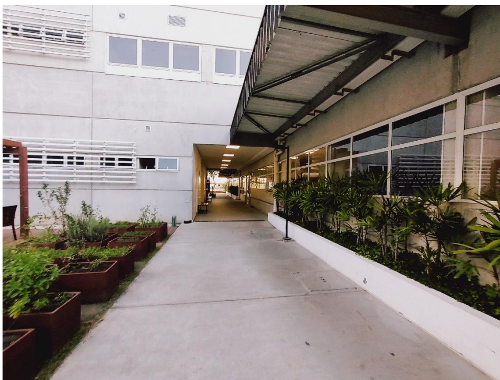
Vista externa do galpão
