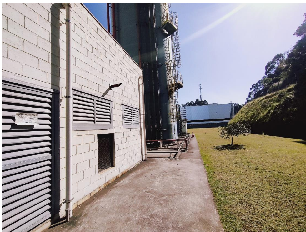
Vista externa do galpão
