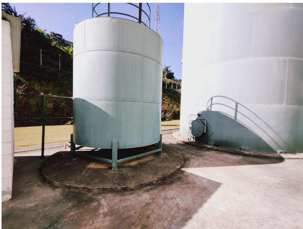
Vista da área técnica (caixa d'água)
