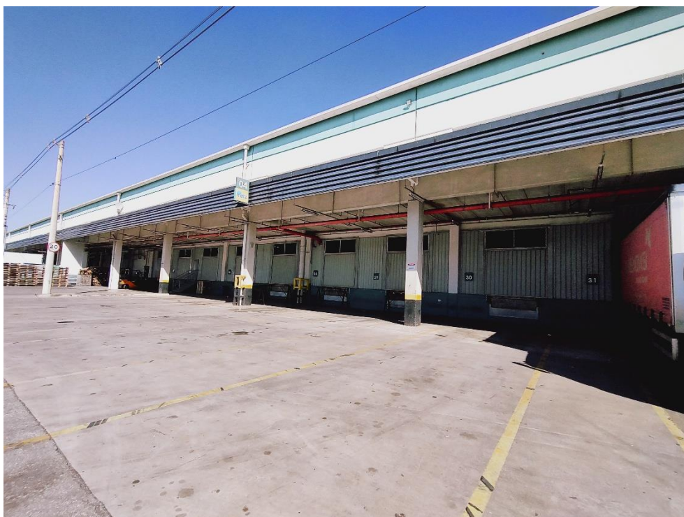
Vista externa do galpão
