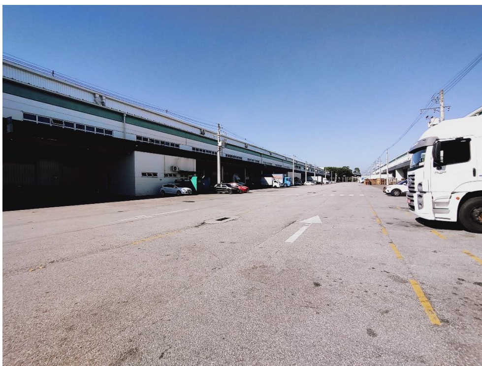
Vista externa do galpão
