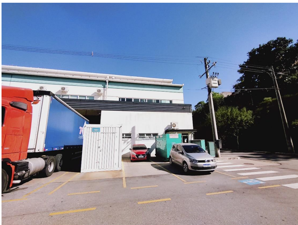
Vista externa do galpão
