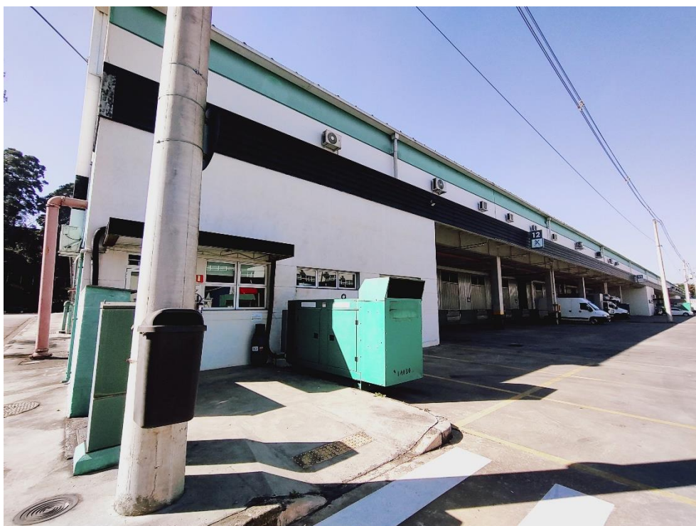
Vista externa do galpão
