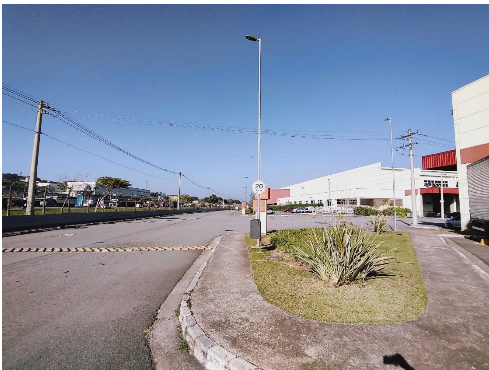
Vista externa do galpão
