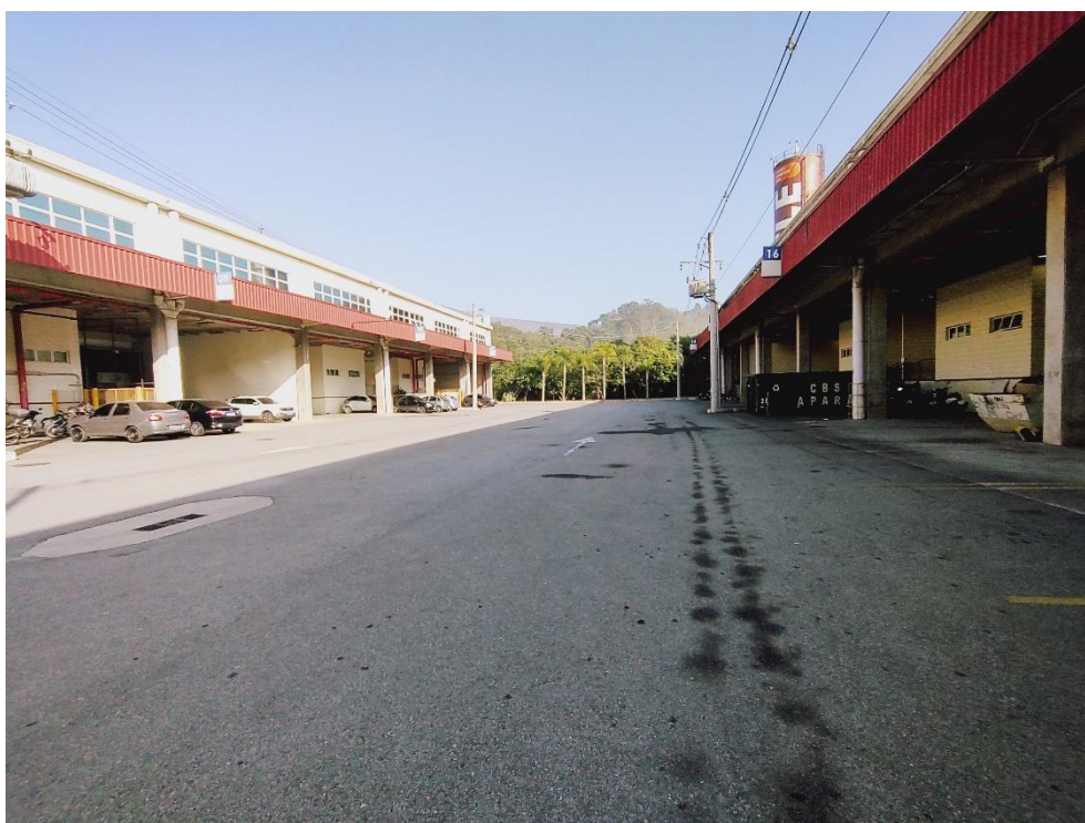
Vista externa do galpão
