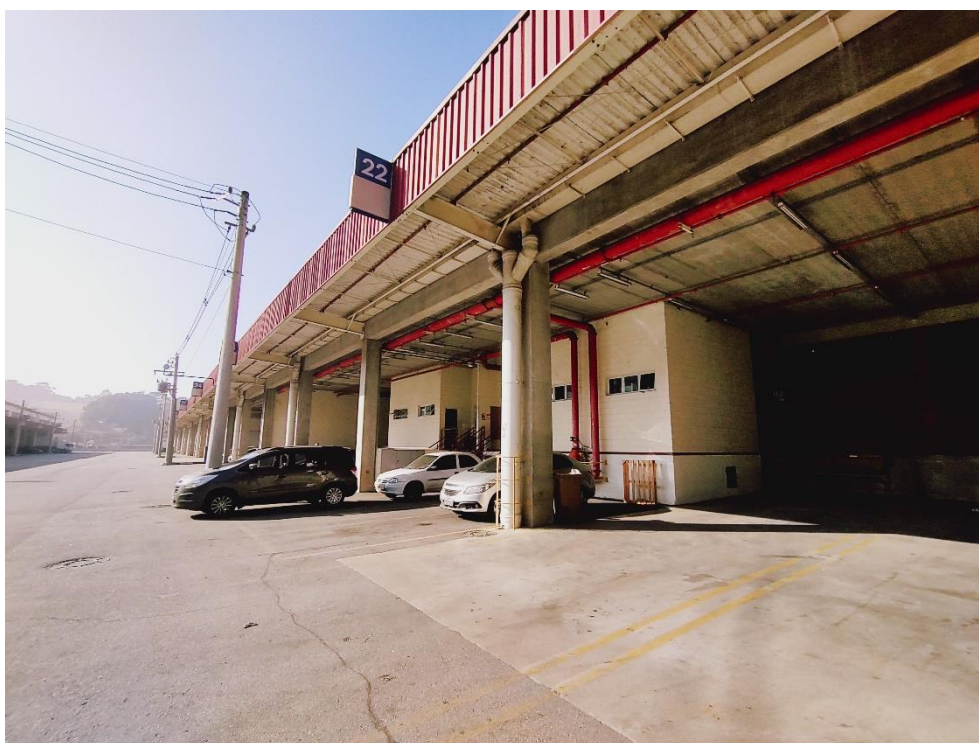
Vista externa do galpão
