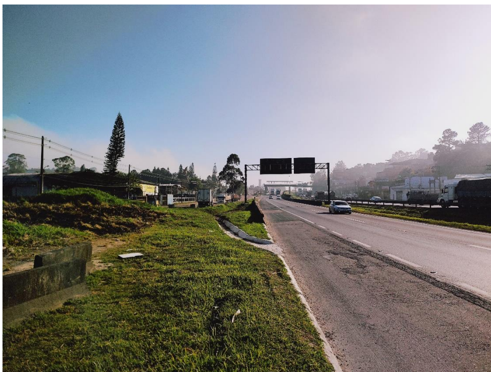
Via de acesso com o imóvel à direita
