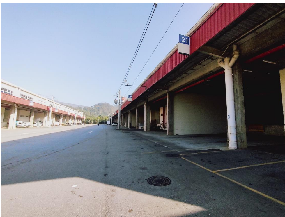
Vista externa do galpão
