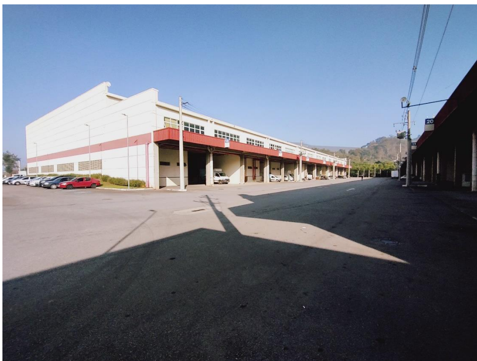
Vista externa do galpão
