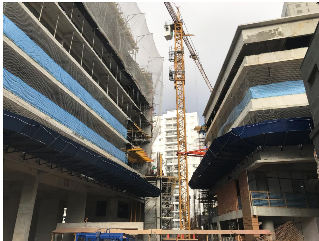
Fotos da obra.
