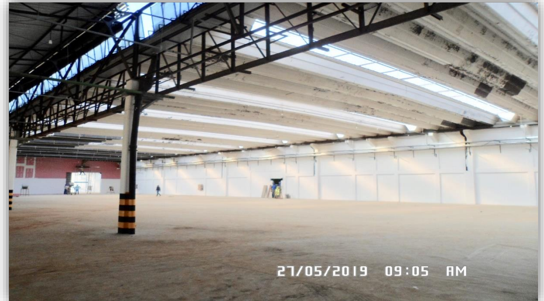
Área Interna do Galpão em Fase Final de Obras
