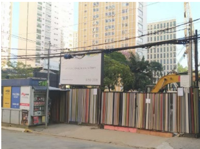
Vista Externa Tapume - Rua Itacema. Fonte: Planservice.
