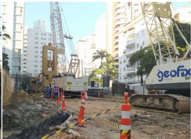
Vista Interna Tapume - Máquinas em Operação. Fonte: Planservice.
