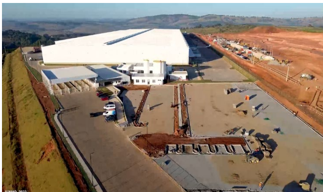
Visão geral entrada do condomínio com portaria e áreas comuns.
