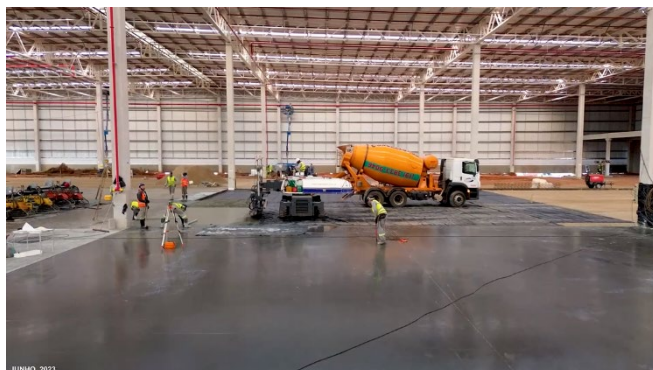
Concretagem de piso.
