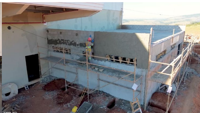
Acabamentos Núcleo Recepção/Vestiários Módulo 13.
