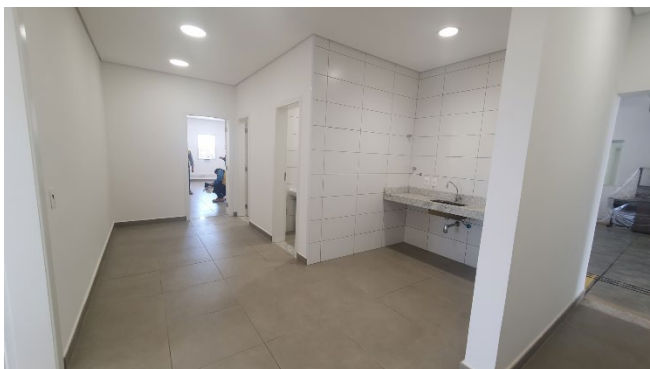
Copa, sanitários e sala de notas do condomínio.
