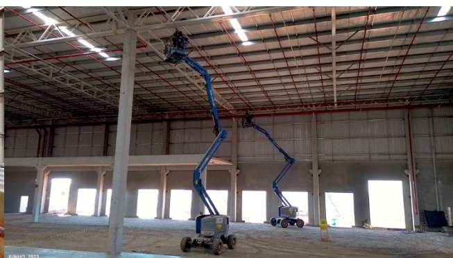
Execução Instalações Módulo 13.
