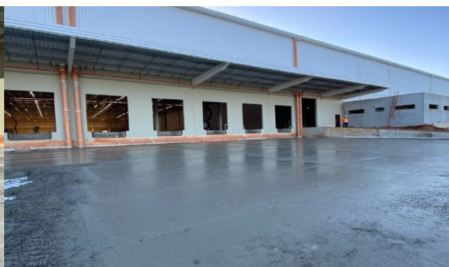
Concretagem pavimento de concreto docas eixo J.
