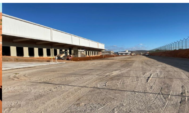
Execução da base de pavimento eixo A.
