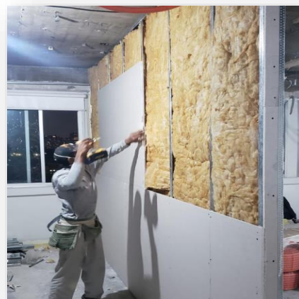
Status atual da obra (2ª semana)
