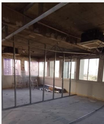
Início da obra
