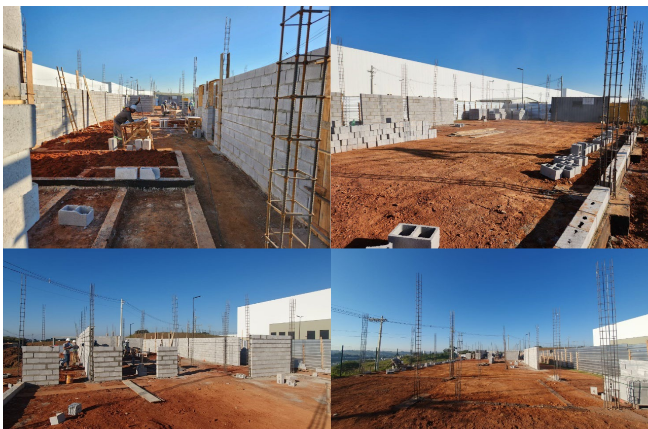
Foto obra restaurante Citlog Sul de Minas.
