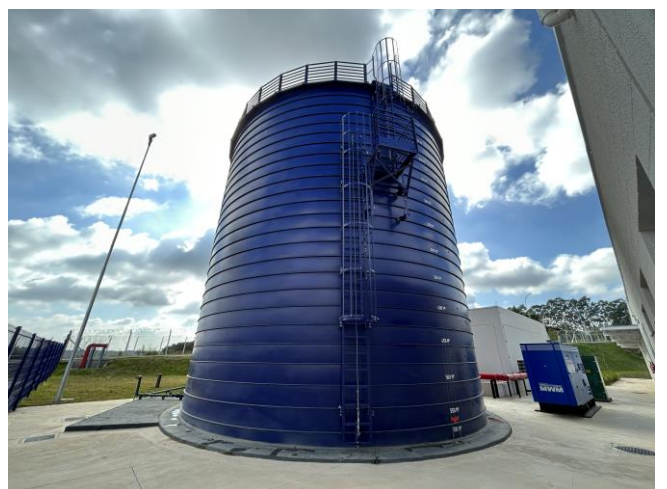
RESERVATÓRIO DE ÁGUA
