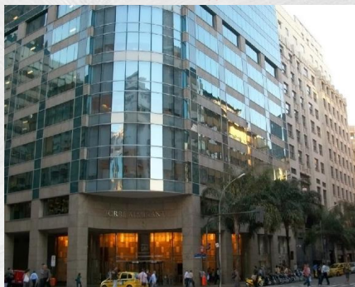
Torre Almirante - RJ
