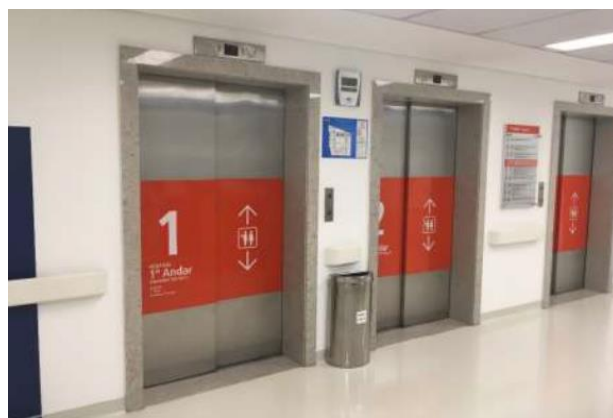
Hall dos Elevadores
