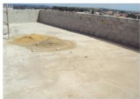
VISTA DA COBERTURA E ALVENARIA NAS PLATIBANDAS
