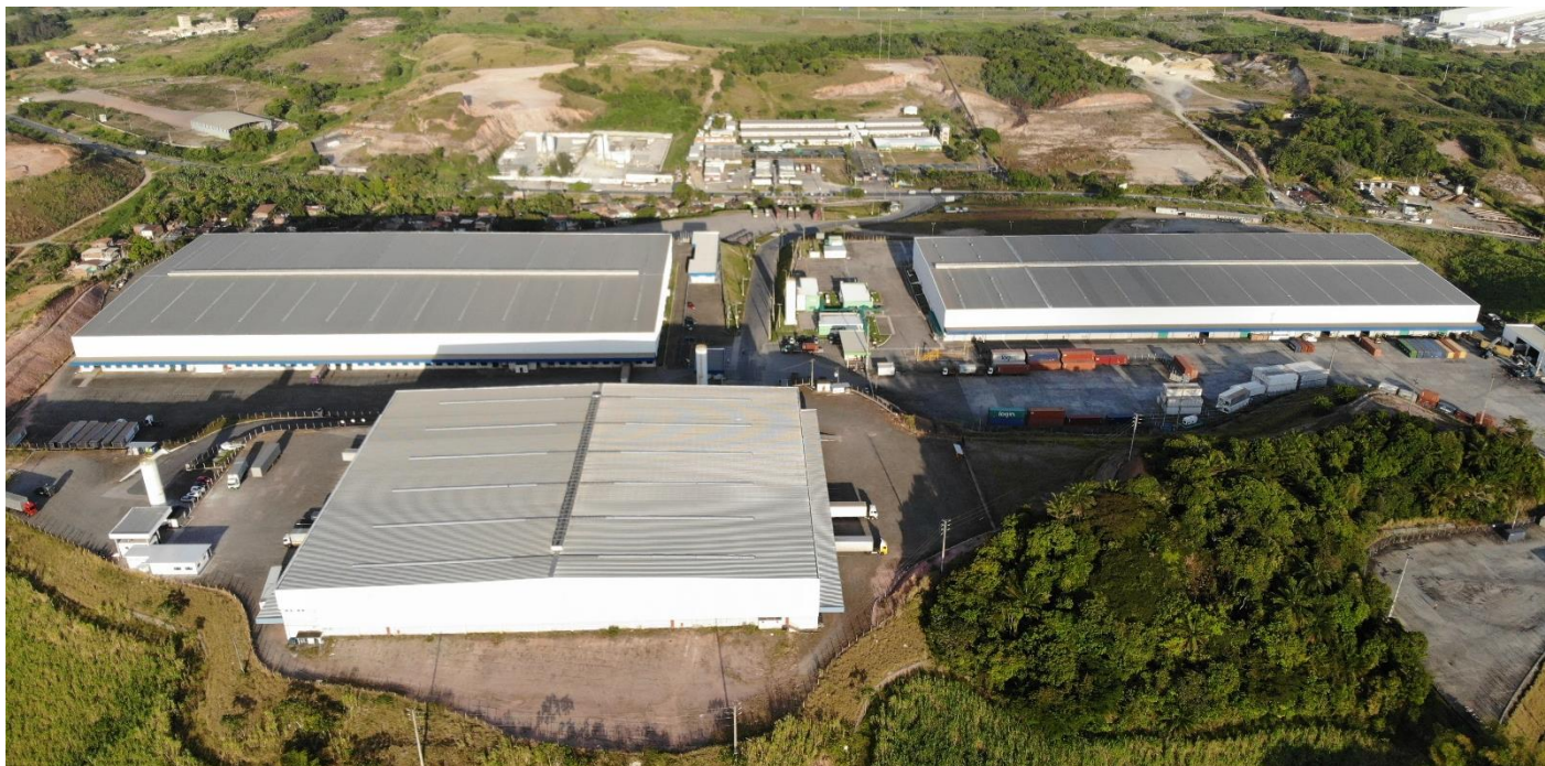
Imagem 3: Foto Aérea dos Galpões
