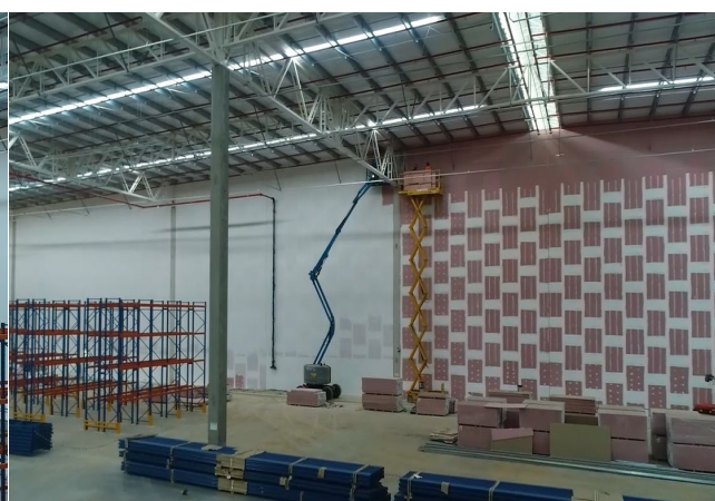
Montagem da divisória da Área BTS.
