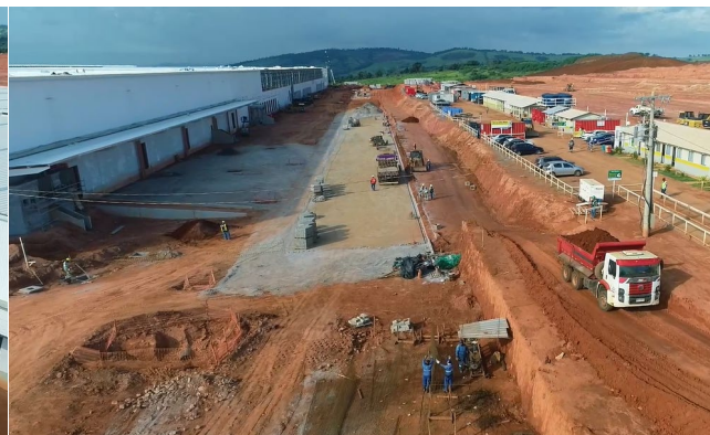
Pavimentação da circulação e docas – eixo A.
