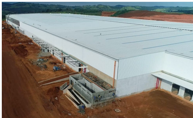
Docas, recepção e vestiários Área BTS.
