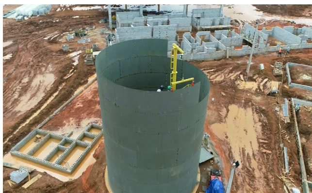
Montagem de reservatório de incêndio.
