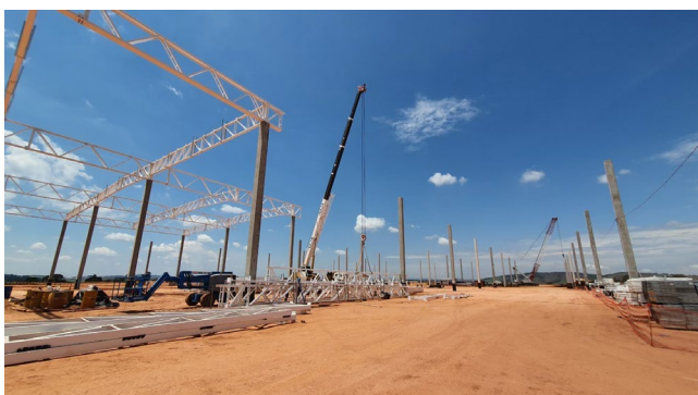
Montagem de pilares pré-moldados e estrutura de cobertura do galpão.
