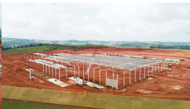
Visão geral do galpão (outubro).
