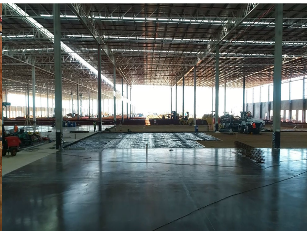
Visão geral área interna do galpão.
