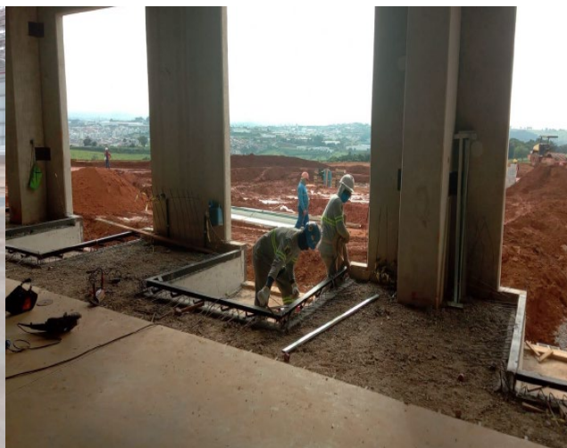
Execução dos nichos de niveladoras de docas.
