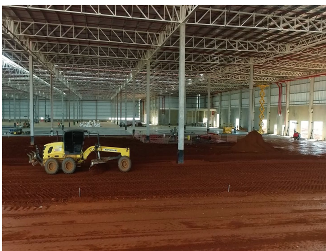
Tratamento de base para o piso do galpão.
