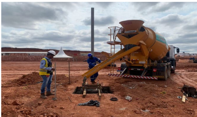
Fundação: execução de blocos
