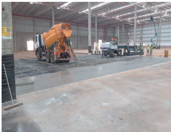
Concretagem do piso do galpão.
