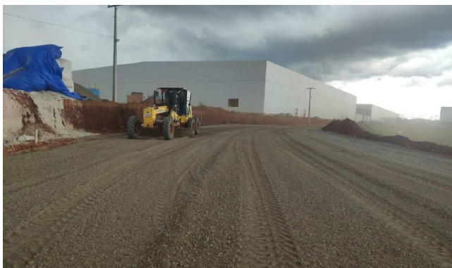
Preparo de base de pavimento intertravado.
