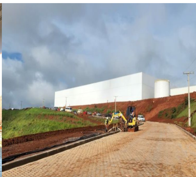
Pavimentação do viário de acesso.
