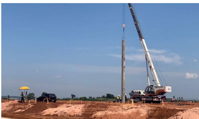
Montagem de pilares pré-moldados.
