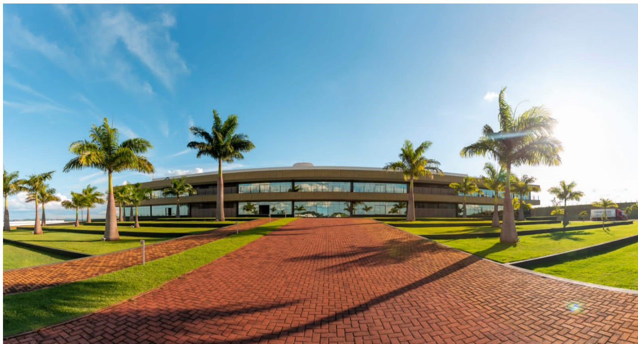
Fachada do Porto Seco Sul de Minas.
