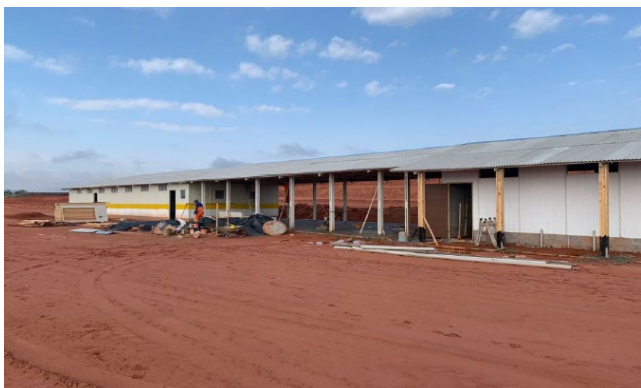
Montagem de canteiro de obras.
