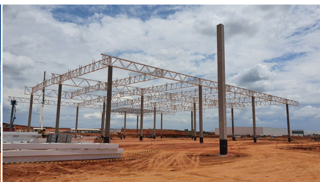
Estrutura de cobertura do galpão.
