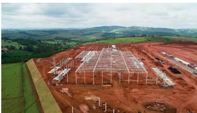
Visão geral do galpão (outubro).
