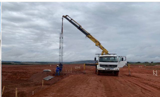
Fundação: execução de estacas.
