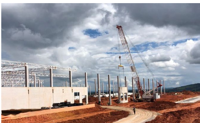
Montagem de painéis Tilt-up.
