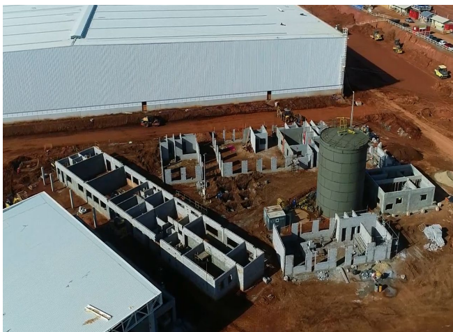
Edificações das áreas comuns do condomínio.
