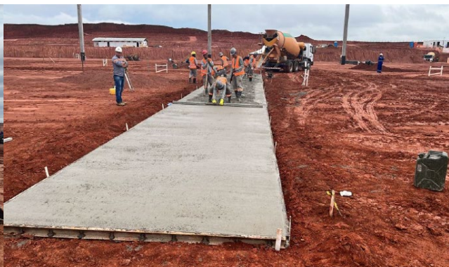
Execução de pista de fabricação de pilares
