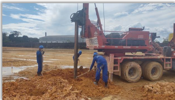
Escavação das estacas
