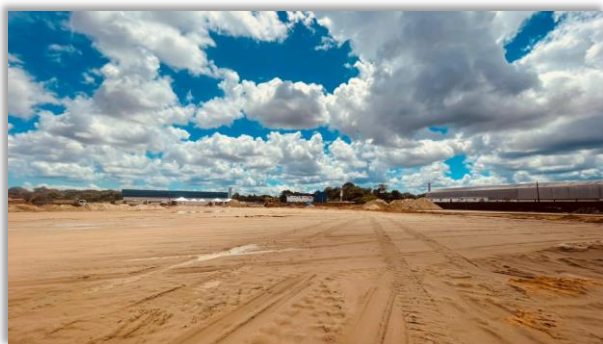
Preparo do terreno com areia de fundo de rio
