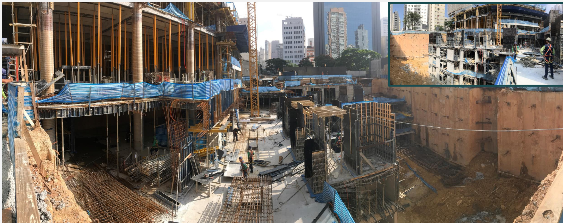
H.I. Pinheiros | Foto da Obra
