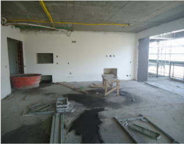
VISTA DA SALA DE ESTAR/ JANTAR - APARTAMENTO 701
