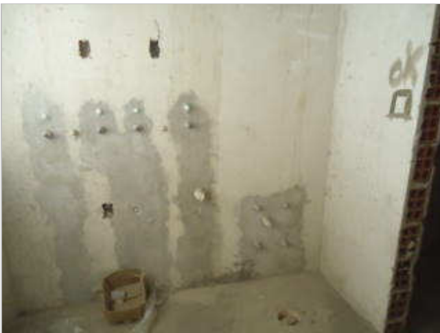
VISTA DO LAVANDERIA - APARTAMENTO 701
