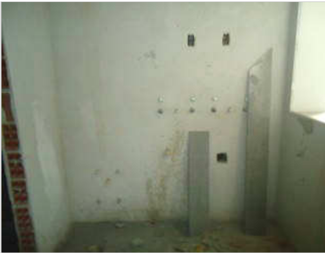
VISTA DO LAVANDERIA - APARTAMENTO 501
