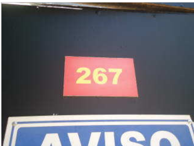
VISTA DO NÚMERO DE IDENTIFICAÇÃO DO EDIFÍCIO
