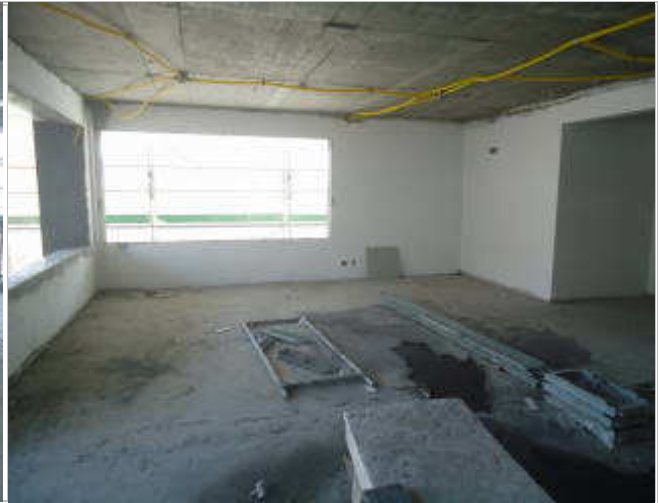
VISTA DA SALA DE ESTAR/ JANTAR - APARTAMENTO 701
