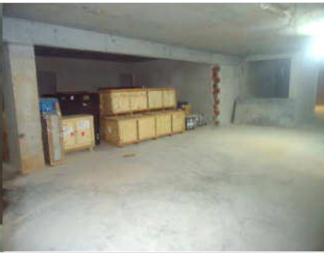
VISTA ÁREA DE ESTACIONAMENTO 2º SUBSOLO
