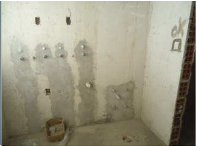
VISTA DO LAVANDERIA - APARTAMENTO 602
