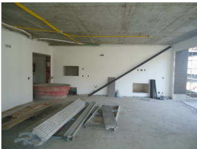
VISTA DA SALA DE ESTAR/ JANTAR - APARTAMENTO 501
