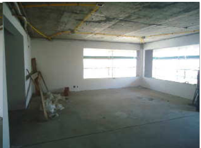
VISTA DA SALA DE ESTAR/ JANTAR - APARTAMENTO 602
