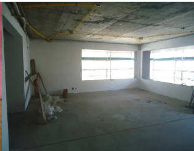
VISTA DA SALA DE ESTAR/ JANTAR - APARTAMENTO 501
