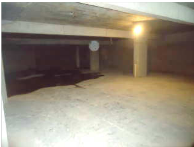
VISTA ÁREA DE ESTACIONAMENTO 2º SUBSOLO
