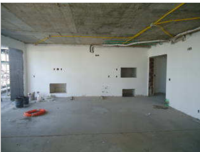
VISTA DA SALA DE ESTAR/ JANTAR - APARTAMENTO 602
