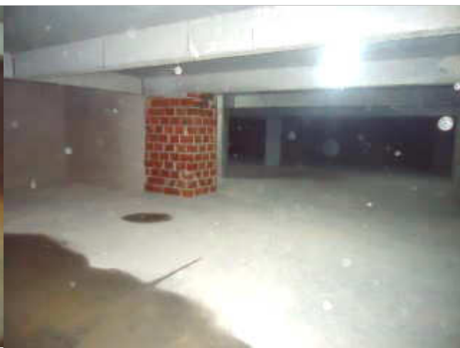
VISTA ÁREA DE ESTACIONAMENTO 2º SUBSOLO
