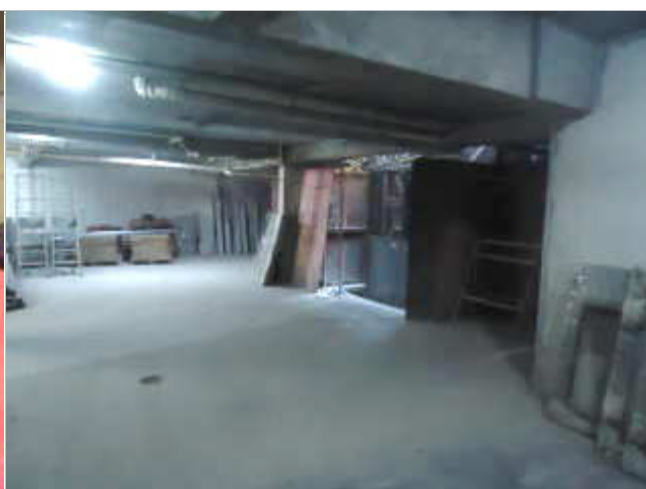
VISTA ÁREA DE ESTACIONAMENTO 1º SUBSOLO
