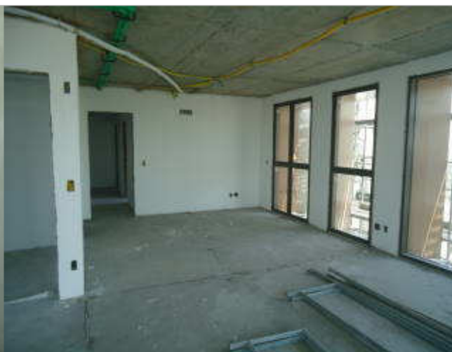
VISTA DA SALA DE ESTAR/ JANTAR - APARTAMENTO 901
