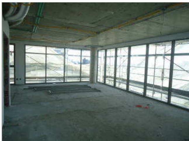
VISTA DA SALA DE ESTAR/ JANTAR - APARTAMENTO 901
