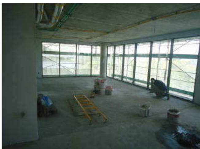
VISTA DA SALA DE ESTAR/ JANTAR - APARTAMENTO 501
