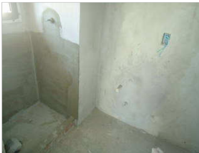
VISTA DO LAVANDERIA - APARTAMENTO 901
