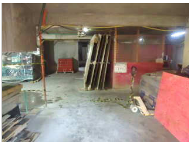
VISTA ÁREA DE ESTACIONAMENTO 1º SUBSOLO
