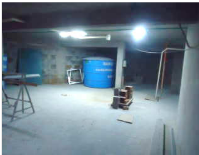
VISTA ÁREA DE ESTACIONAMENTO 2º SUBSOLO
