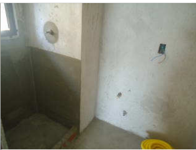
VISTA DO LAVANDERIA - APARTAMENTO 501
