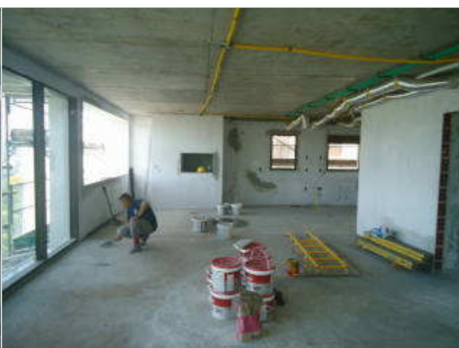
VISTA DA SALA DE ESTAR/ JANTAR - APARTAMENTO 501
