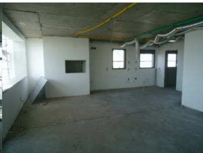
VISTA DA SALA DE ESTAR/ JANTAR - APARTAMENTO 901
