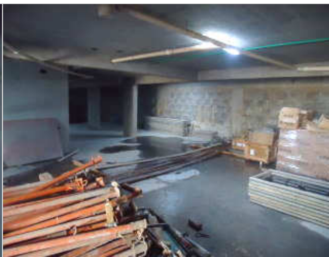
VISTA ÁREA DE ESTACIONAMENTO 2º SUBSOLO
