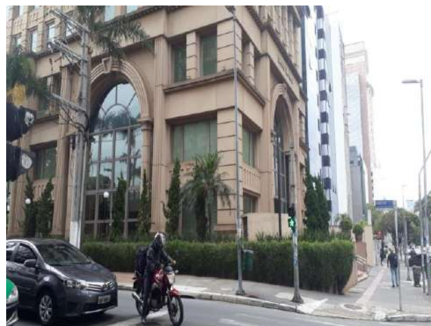
Características do Imóvel Avaliado.
