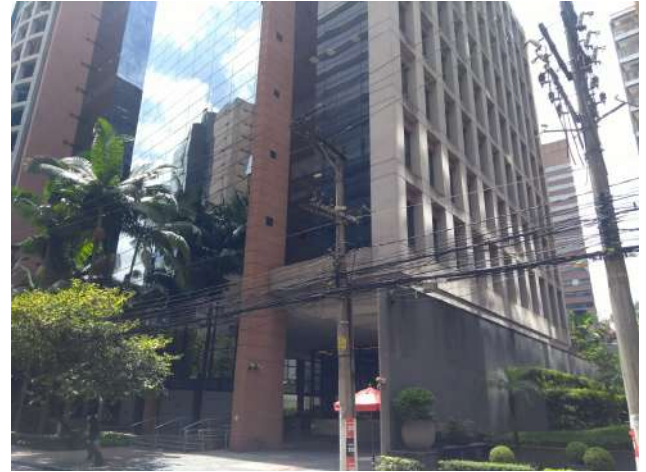
Rua Fidêncio Ramos - Local dos Imóveis Avaliados.
