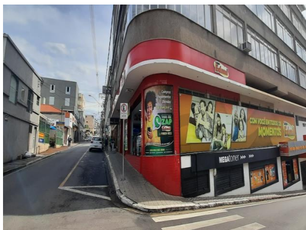
Vista Externa do Imóvel Avaliando - Rua Gonçalves da Guia x Rua Coronel Francisco Manoel Franco.
