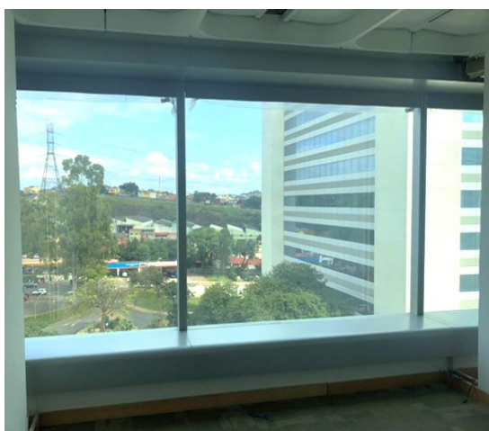
Vista Externa – Andar Tipo
