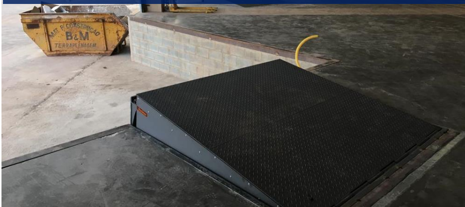
Instalação das niveladoras de docas
