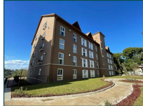
Bloco J - Concluído
