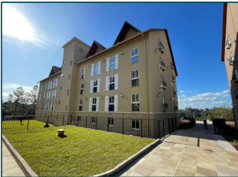
Bloco I - Concluído
