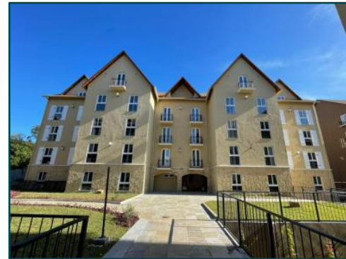
Bloco H - Concluído
