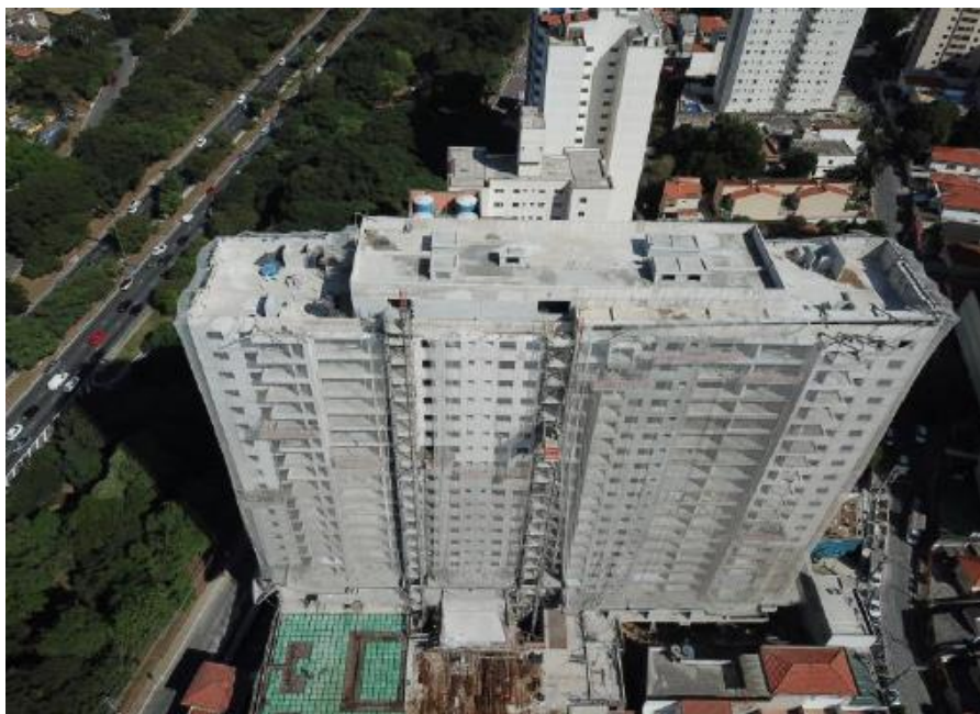
Foto Vista Geral Obra
