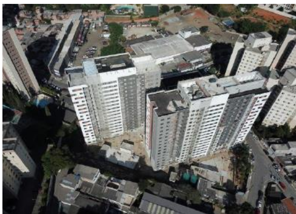
Foto Estrutura Obra
