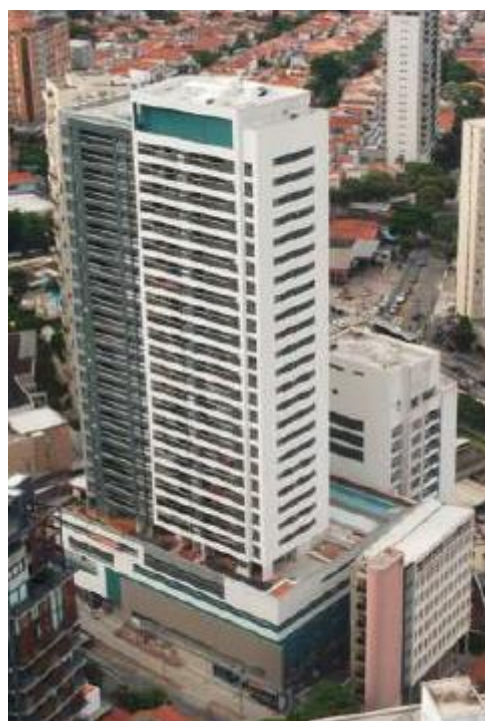
Foto Fachada da Obra - Misce
