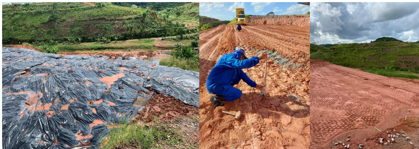
Imagem 6: Reparos no Talude
