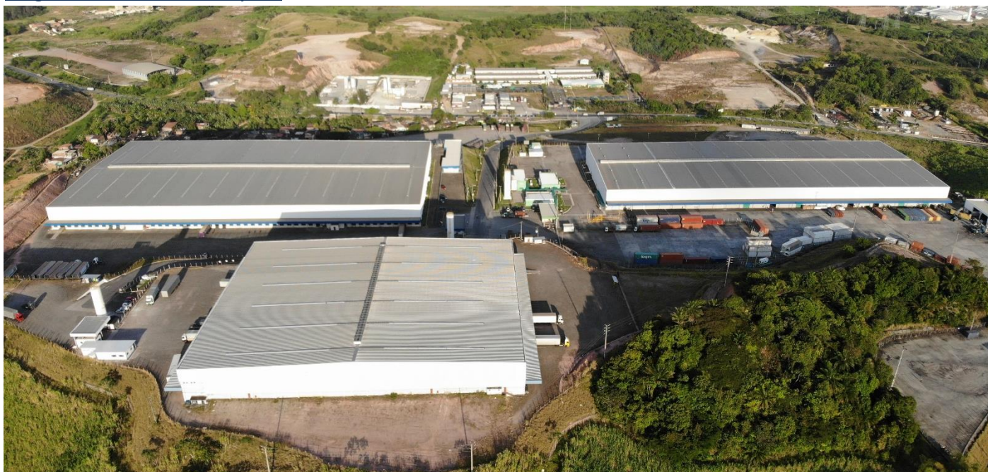
Imagem 3: Foto Aérea dos Galpões
