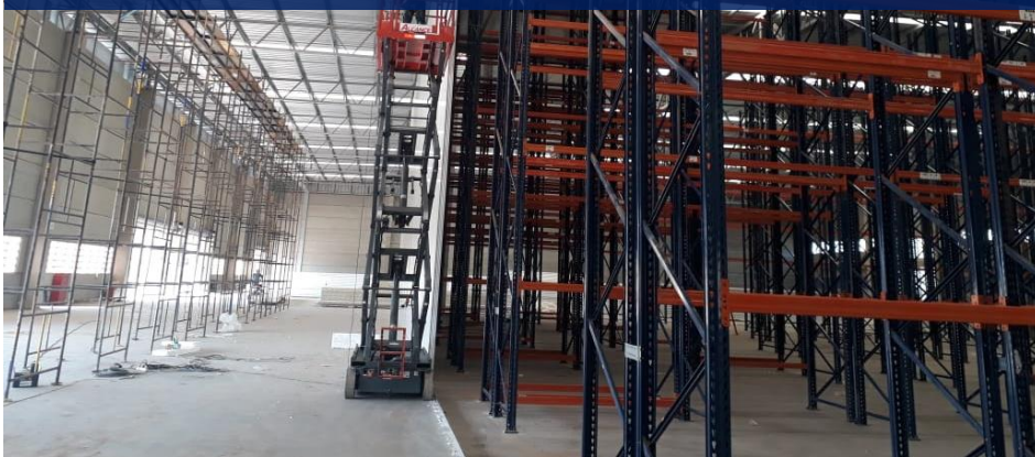
Câmaras Refrigeradas – Montagem
