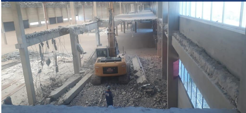
Demolição parcial do mezanino
