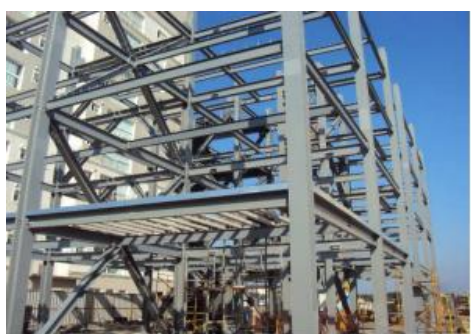
VISTA GERAL DA ESTRUTURA EM MONTAGEM
