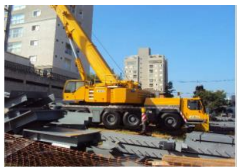
EQUIPAMENTO DE MONTAGEM DE ESTRUTURA
