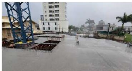
Laje Concretada
