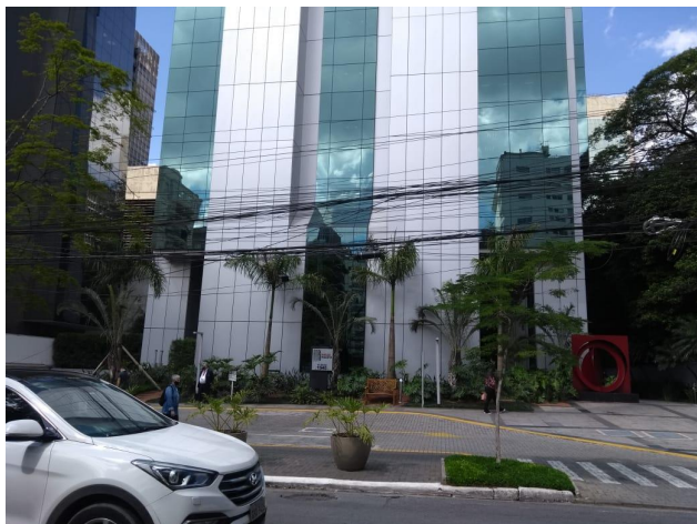
Vista Externa do Imóvel Avaliando.
